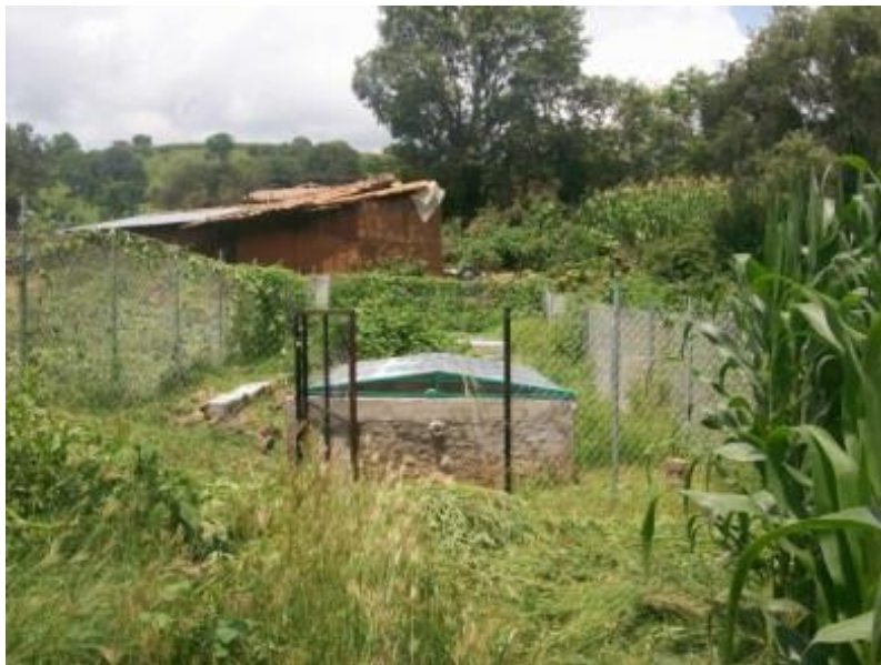
Planta de tratamiento vía humedal
