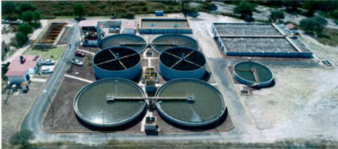
Vista aérea de la PTAR San Juan de los Lagos
