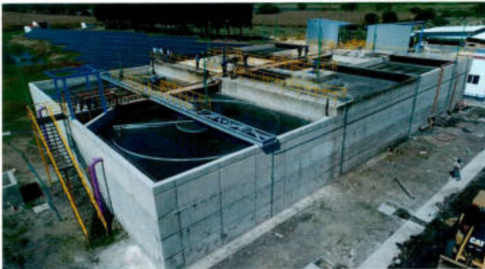
Sembrado general de la PTAR Poncitlán
