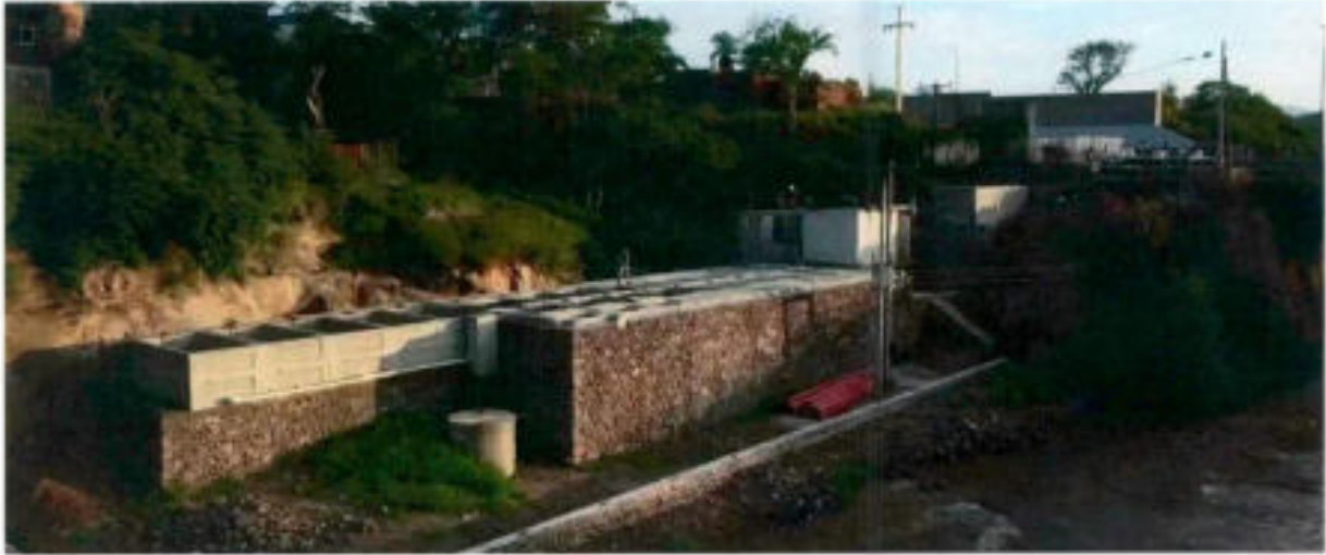
Vista de la PTAR San Martín de Bolaños
