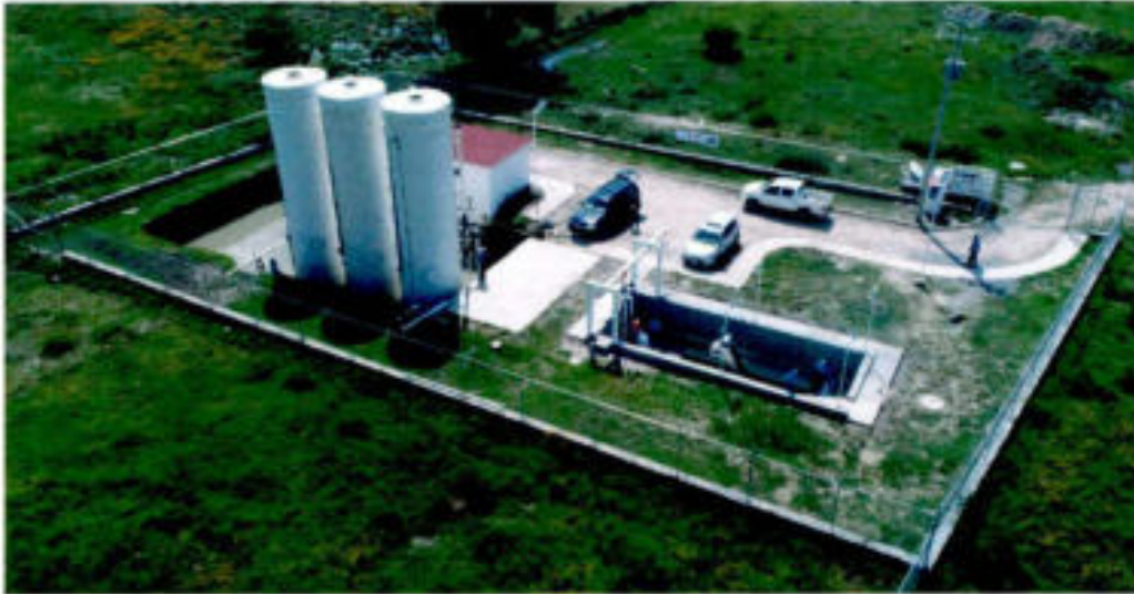
Vista aérea de la PTAR Santa María del Valle
