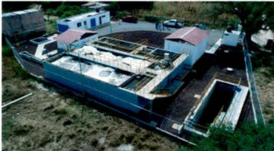
Vista aérea de la PTAR Lagos de Moreno
