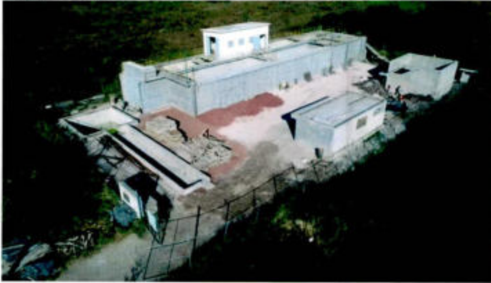
Vista aérea PTAR Varias Localidades Ixtlahuacán de los Membrillos
