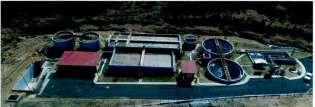
Vista aérea de la PTAR Yahualica
