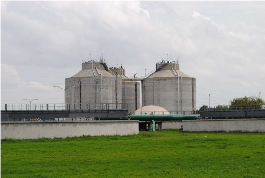
Fotografía 6. Almacén de gas (domo blanco), digestores de lodos.
