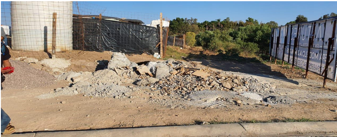
Figura 7- 3. Imagen de la obra Desarrollo Altures Residencial, donde se observa el almacenamiento de los escombros.
