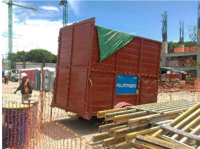
Figura 7- 2. Ejemplo de otra obra, donde se separan materiales como madera y poliestireno para su posterior reutilización.
